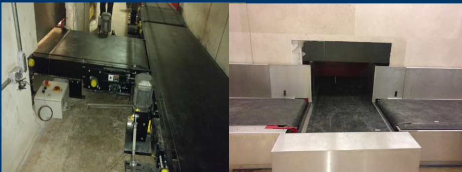
Modificación de conveyor's en la terminal tres del aeropuerto de Cancún
